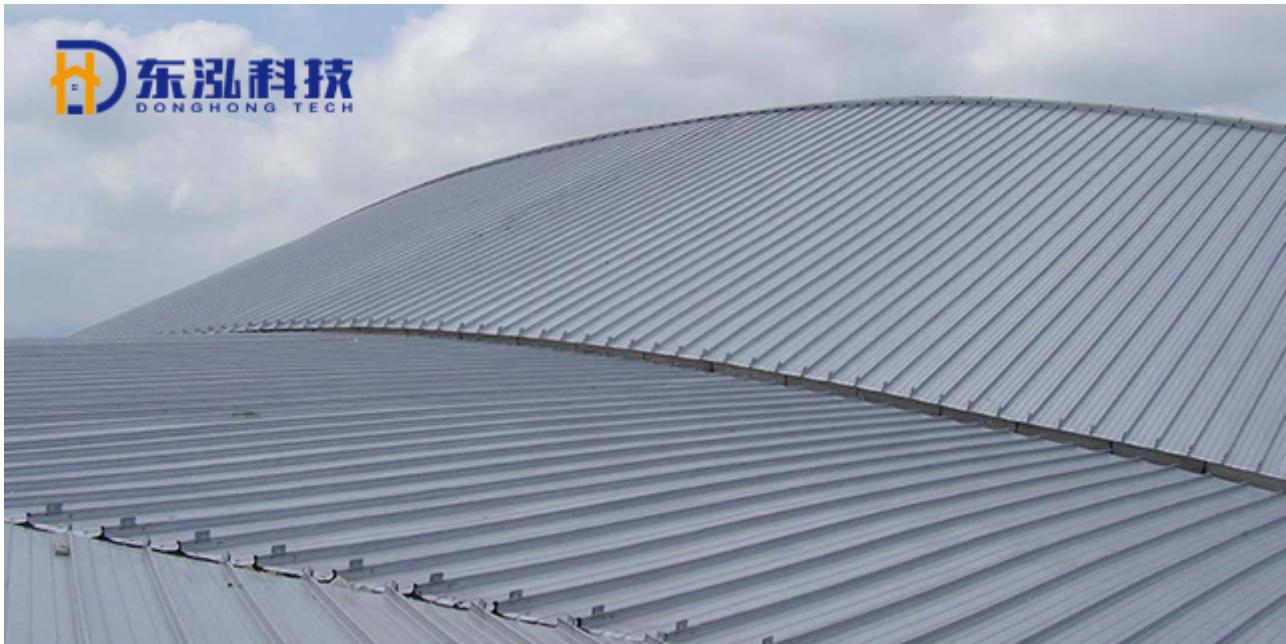
厚度一般为0.4[1.5mm]板的表面一般进行涂装处理。由于材质及涂层质量的不同,有的板寿命可达50年以上。板的制作形状有多种多样,有的为复合板,即将保温层复合在两层金属板材之间,也有的为单板,施工时,有的板在工厂加工好后现场组装,有的根据屋面工程的需要在现场加工。保温层有的在工厂复合好,也可以在现场制作。所以金属板材屋面形式多样,从大型公共建筑到厂房、库房、住宅等均有使用。故规范规定金属板材屋面的适用范围为防水等级为I[II]III级的屋面。
